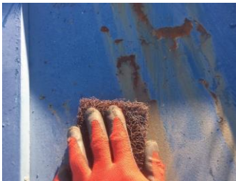
Loại bỏ gỉ trong khu vực thi công rộng
