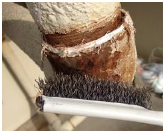
Loại bỏ gỉ trong khu vực thi công hẹp
